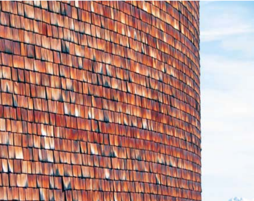
Miljøvennlig materialbruk med ubehandlet, skåret flisledning på kapell i Sumvitg. Arkitekt: Peter Zumthor. FOTO: NAL | ECOBOX.
