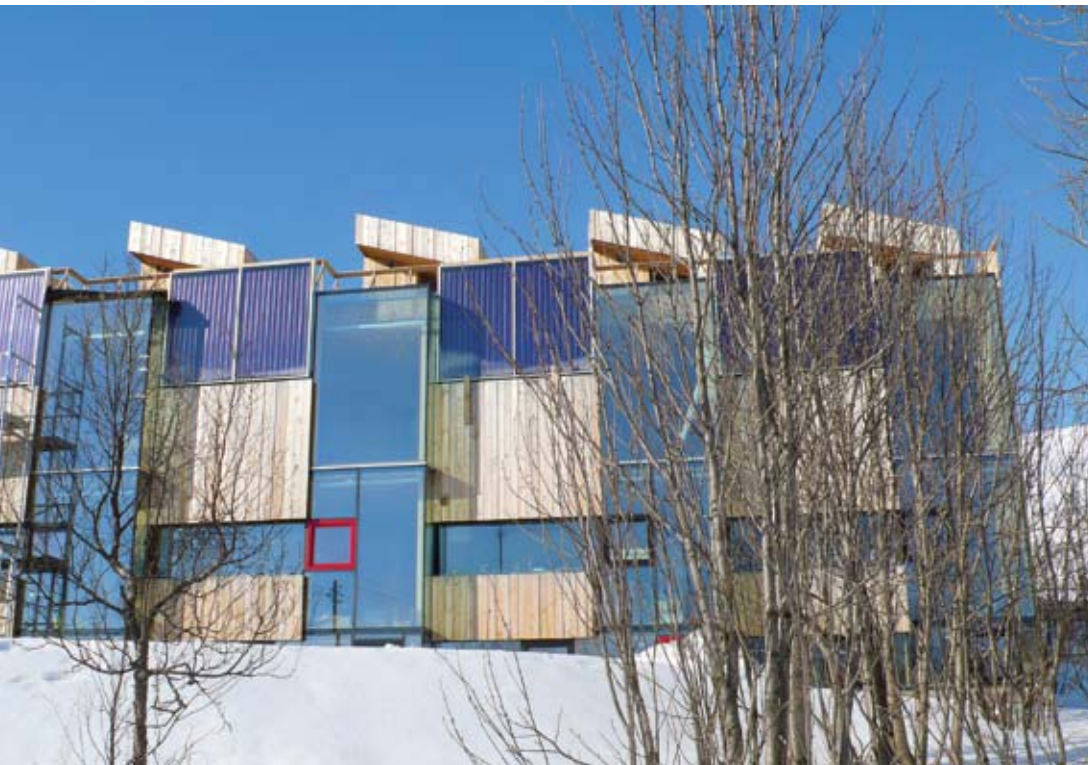
I-box passivhusrekke, Trømsø. Arkitekt: Steinsvik Arkitektkontor AS. FOTO: ROSE MARIE STEINSVIK.
